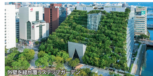
外壁を緑が覆うステップガーデン
